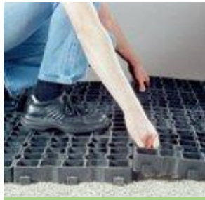
STEP 3 ALIGN GRID
